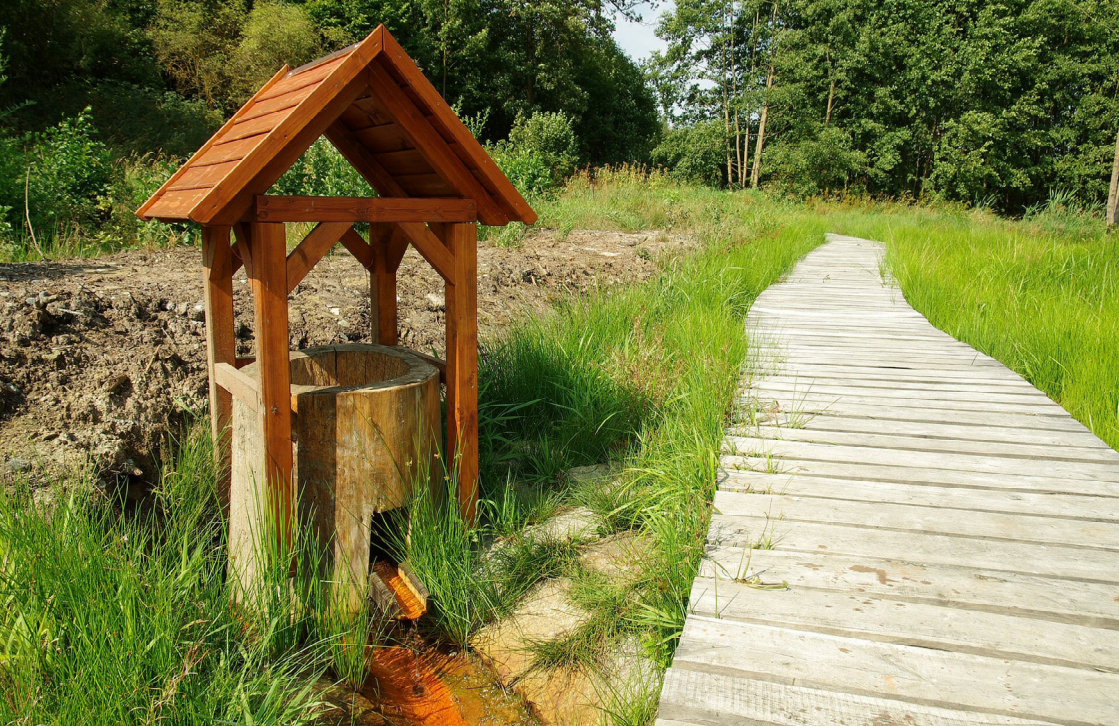
Současná podoba vývěru po provedených úpravách se zastřešením. Foto Jaromír Bartoš.
